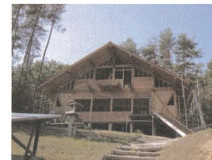
建築中の研修施設「森の教室」（広島地区）
