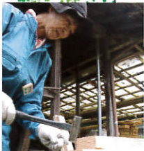
釘打ちの様子
