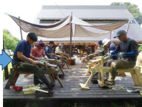
●ウッドデッキ新設
