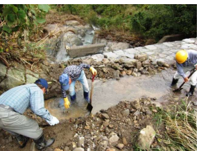
●水道補修（横畑集落）
