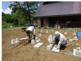
●ウッドデッキ整備
